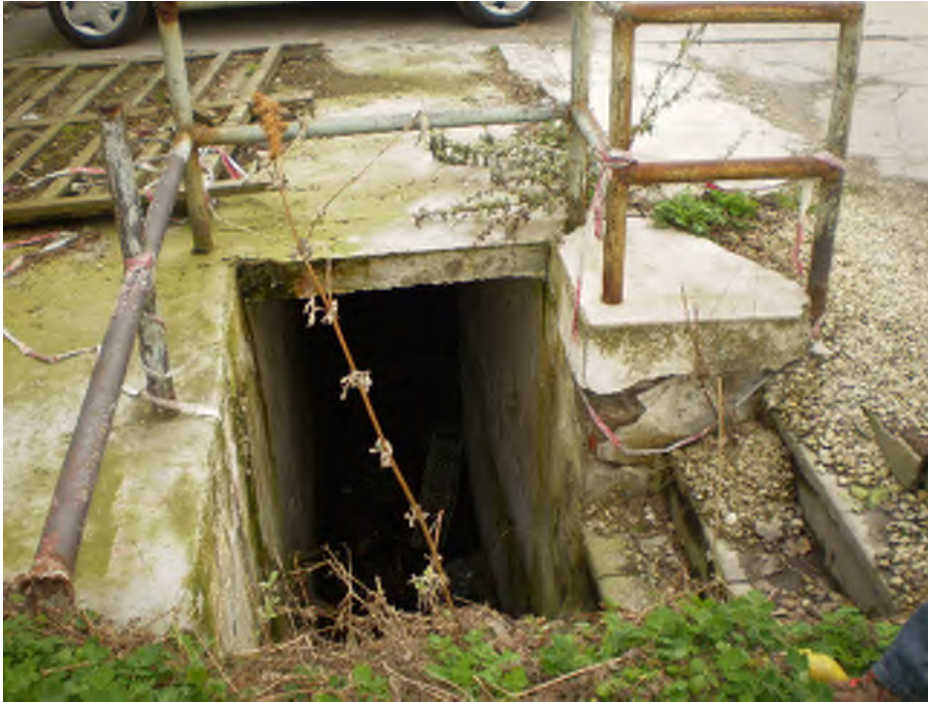
afbeelding 13. Lage Barakken - inrit: aan zuidzijde kelderruimtes aanwezig
