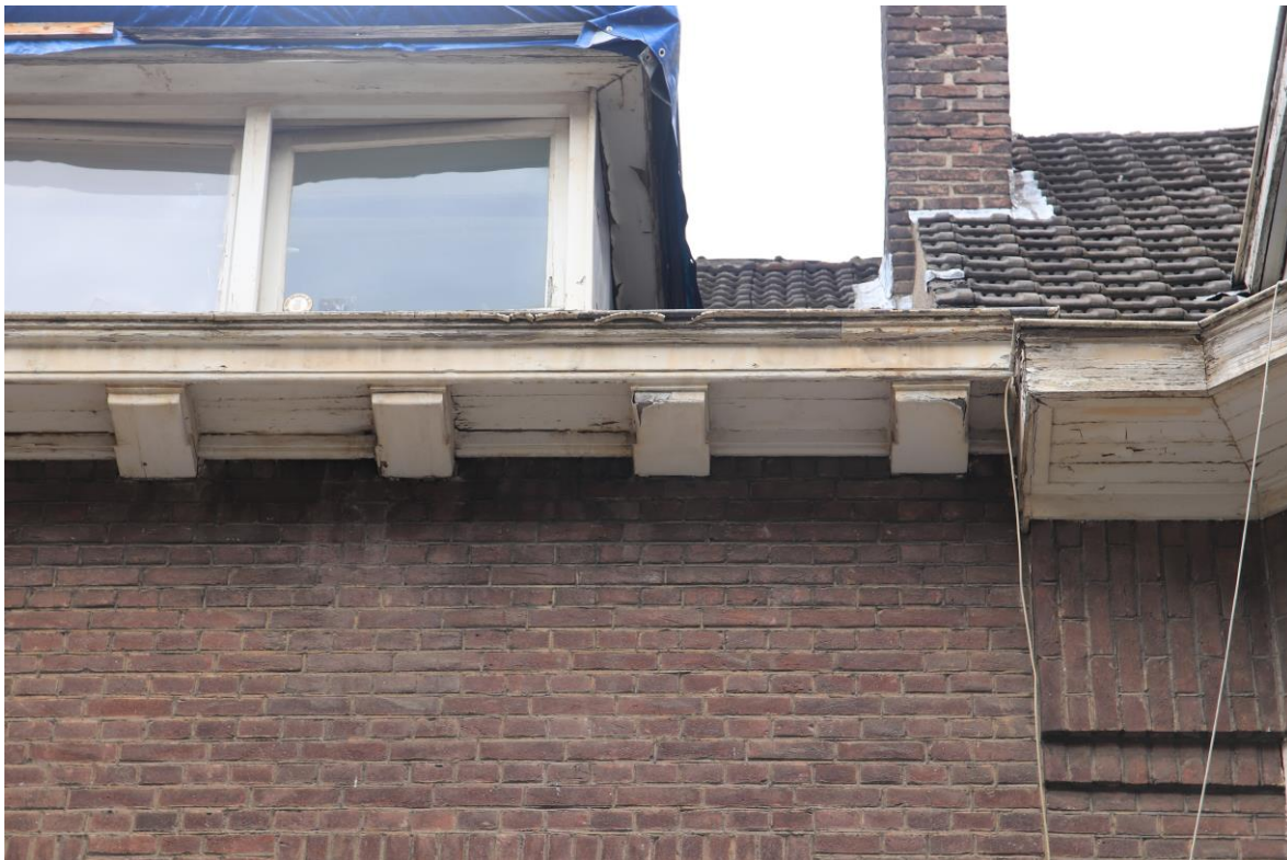
Foto 4: nergens onder de dakgootconstructie zijn geschikte invliegingplekken voor gierzwaluwen
