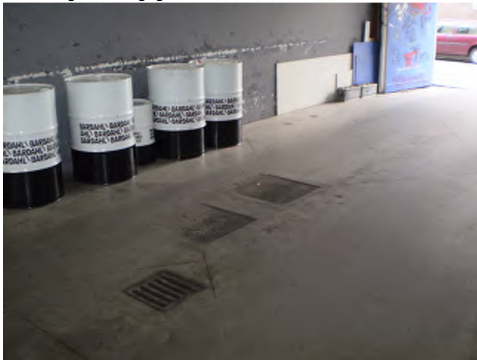
afbeelding 19. Bourgognestraat 36-38 - oliebenzineafscheider
