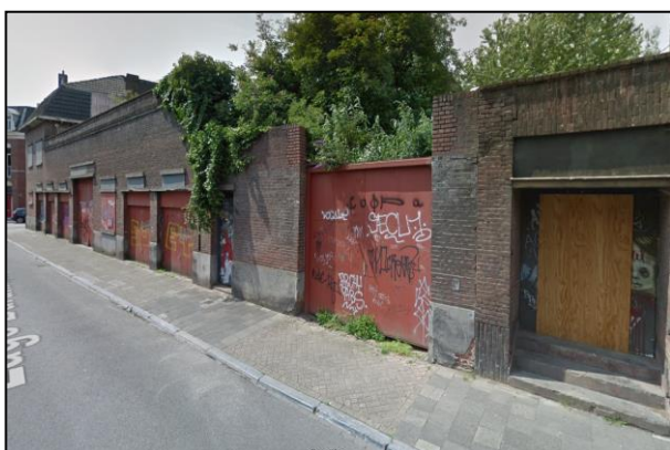
Garagepoorten aan de Lage Barakken
