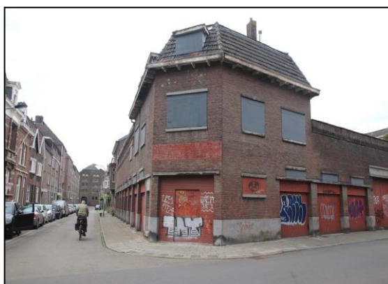
Zicht op hoek Lage Barakken/Bourgognestraat
