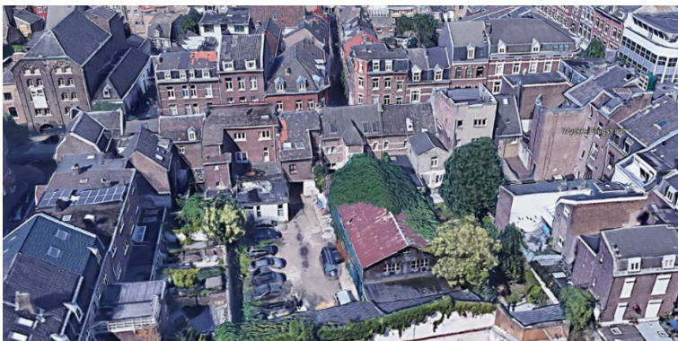
Figuur 7 Achtergevels Wycker Grachtstraat
