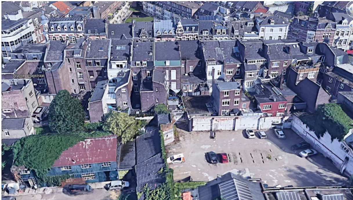
Figuur 10 Wycker Brugstraat: achtergevels
