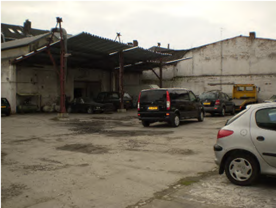
afbeelding 14. Lage Barakken - autostalling
