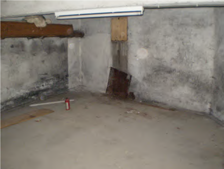
afbeelding 32. Lage Barakken - kelder in dit pand
