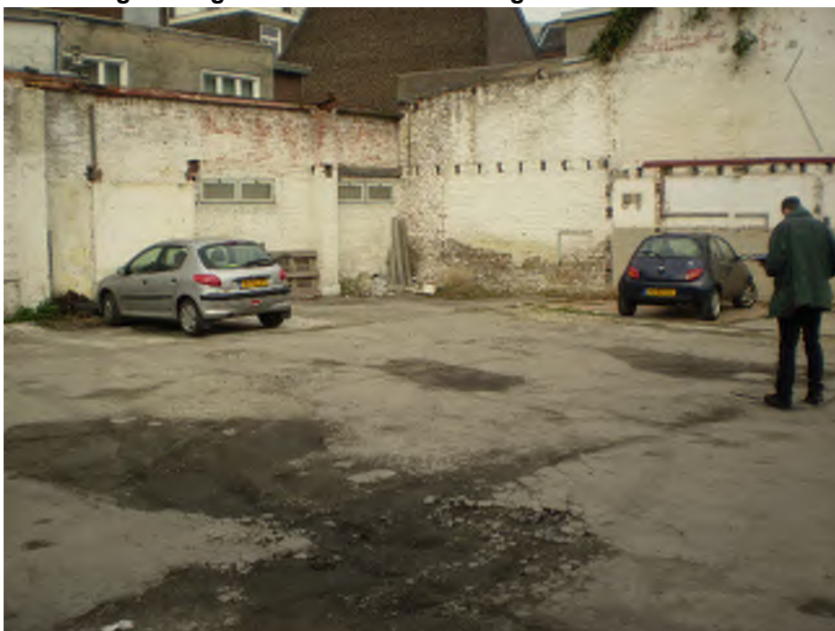
afbeelding 16. Lage Barakken - autostalling met in de hoek asbestverdacht materiaal
