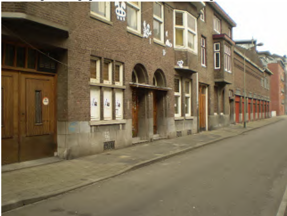
afbeelding 3. Bourgognestraat 30-34 - deel van de gevel
