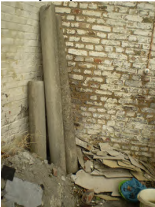
afbeelding 17. Lage Barakken - asbestverdacht materiaal
