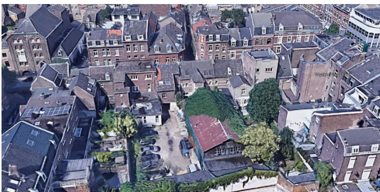
Figuur 8 Achtergevels Wycker Grachtstraat
